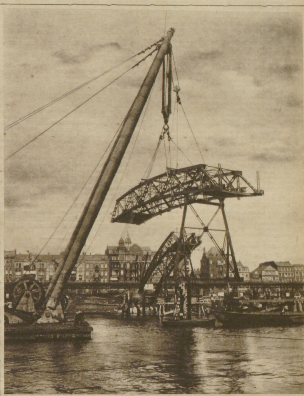
Beim Montieren der neuen Brücke bei den Dorfen in Hamburg.
