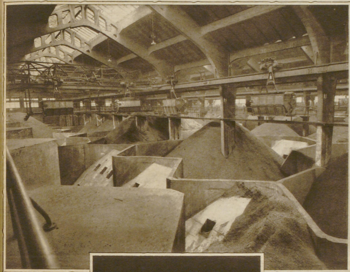
Die Kohlenilos werden durch eine automatische Wagenführung beschickt.
