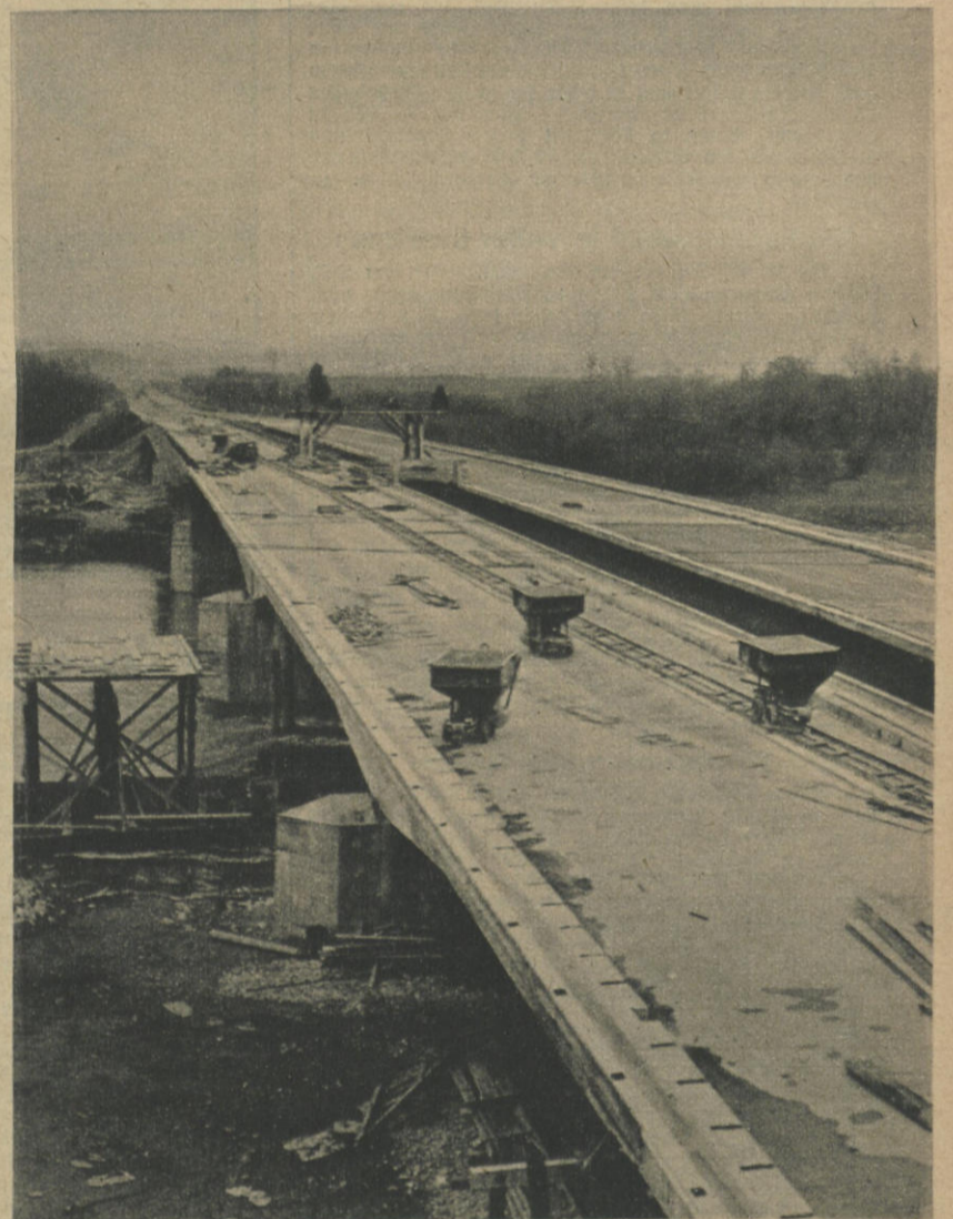
Im Zuge der Reichsautobahn München-Landesgrenze ist jetzt die größte Eisenbetonbalkenbrücke der Welt fertiggestellt worden, die bei Pfraundorf den Inn in einer Länge von 256 m überbrückt Presse-Jll, Hoffmann
