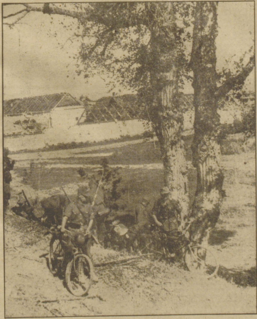
Wie der OKW-Bericht der letzten Tage meldete, fanden am Terekfluß im Kaukasus harte Kämpfe statt. Während die Truppen vorgegangen sind, übernehmen bereits Männer des Reichsarbeitsdienstes dringende Bauarbeiten. Unser Bild zeigt Männer des RAD, die eben von ihren Rädern abgesehen sind, um zur Arbeit eingesetzt zu werden.
