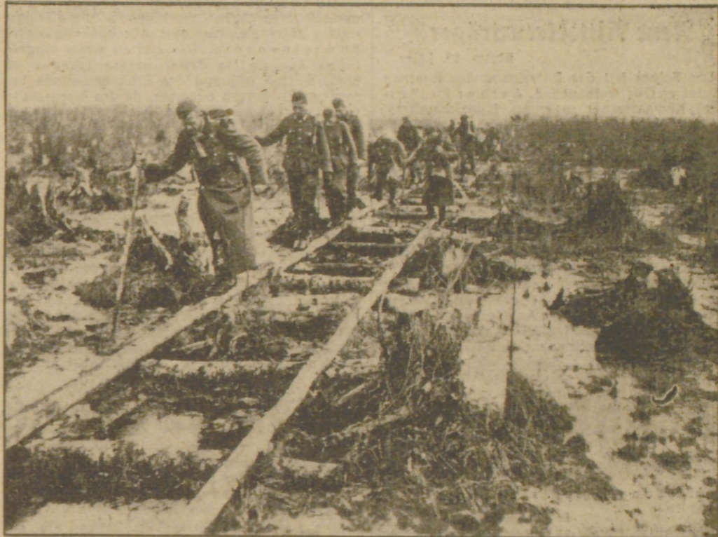
Eine Kolonne von Munitionsträgern arbeitet sich mühsam auf den endlosen Knüppeldämmen durch das Sumpfgelände zu den Stellungen vor. Das Tauwetter hat den gewohnten Morast noch schwerer passierbar gemacht. Vereinzelt ragen noch Bäume über das teils abgeholzte, teils zerschossene Gelände, das die Soldaten des ersten Weltkrieges an den Argonnenwald erinnert. Aufn. Scheer, Bilderdienst
