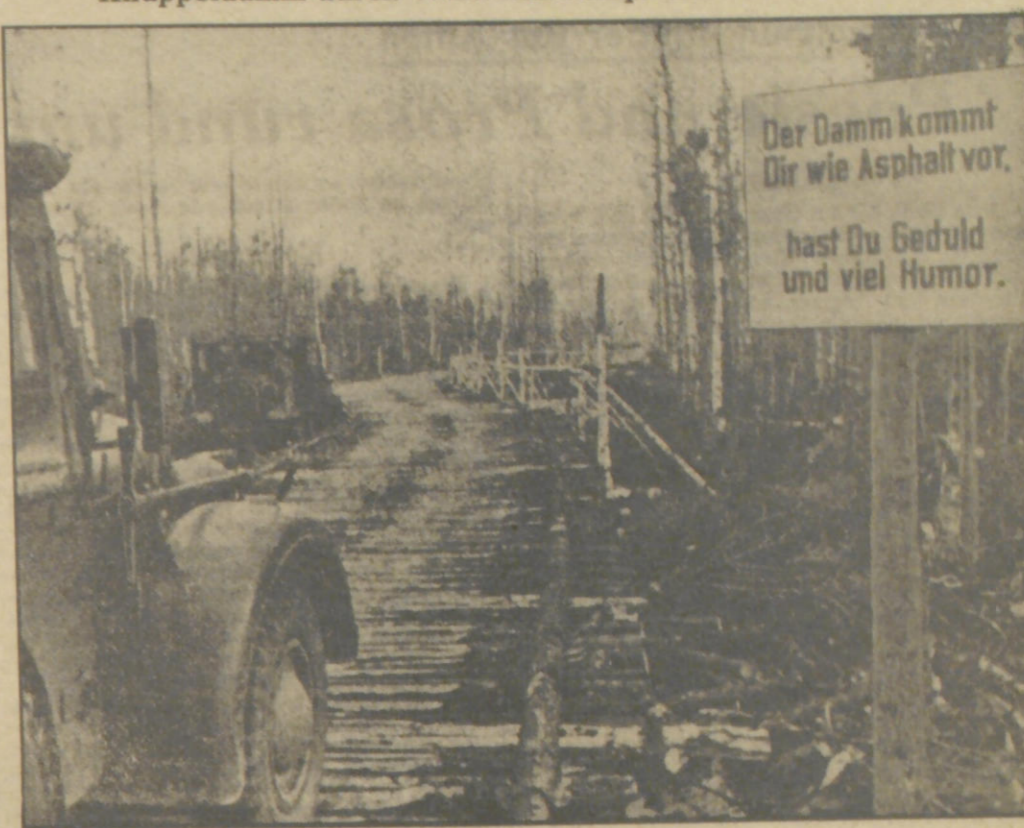
Dort, wo im Sumpfgelände des Wolchow im vergangenen Jahr eine sowjetische Armee vernichtet wurde, führt heute ein neuer, sauberer Knüppeldamm, der zwei Frontabschnitte miteinander verbindet. Gleich am Anfang mußte der Damm, einem riesigen Bombentrichter ausweichen. Das Schild am Birkenzaun macht auf die großen Wasserlöcher aufmerksam. PK-Aufn.: Kriegsberichterstatter Sehtzer (1942)
